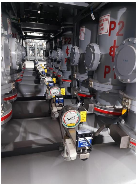
图：变电站内 WAPI 卡片机用于传统表计读数
